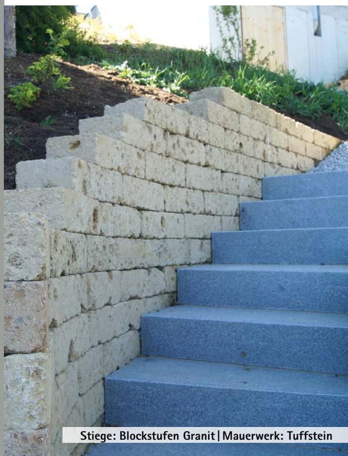
Stiege: Blockstufen Granit | Mauerwerk: Tuffstein
